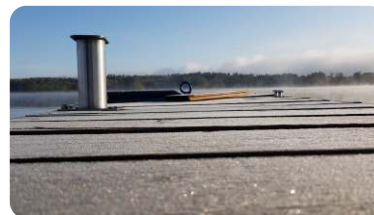
POLER CUMOWNICZY do obkładania cum
